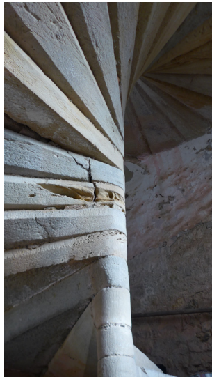
Escalier en vis du XVI e
