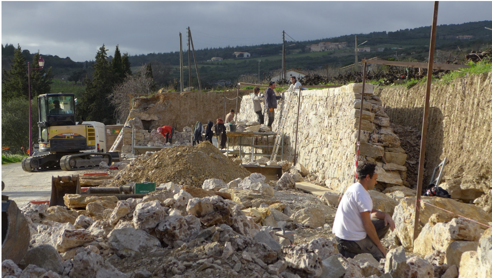
Chantier de mur en pierre sèche à La Caunette
